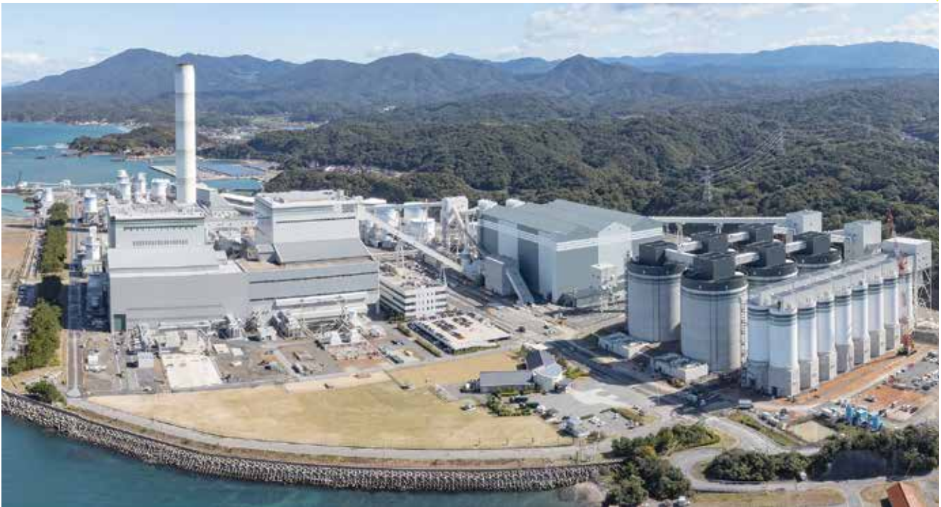
中国電力三隅発電所の全景(煙突の左下が2号機、煙突の高さ200m、直径23m)
